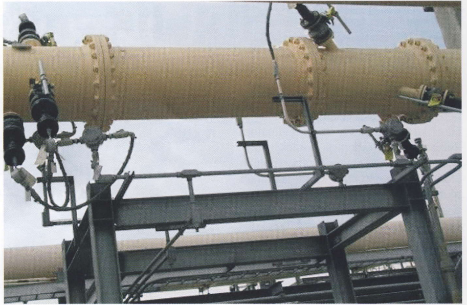
Kuva 4, Neljä mittauskanavaa samassa putkessa 2 x BIAS90 ja 2 x "Diagonal 45"
